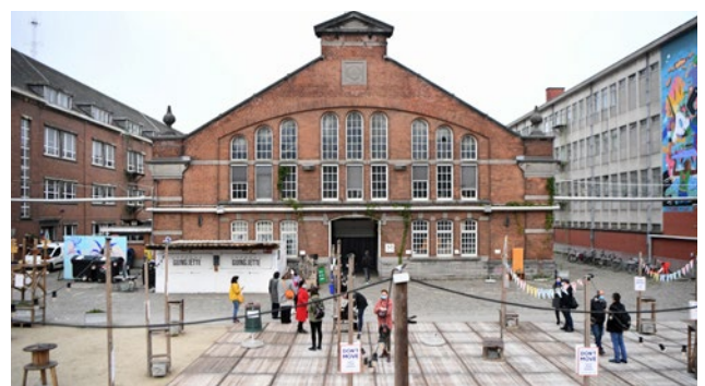
Usquare.brussels, de reconversie van de oude kazerne in Elsene
