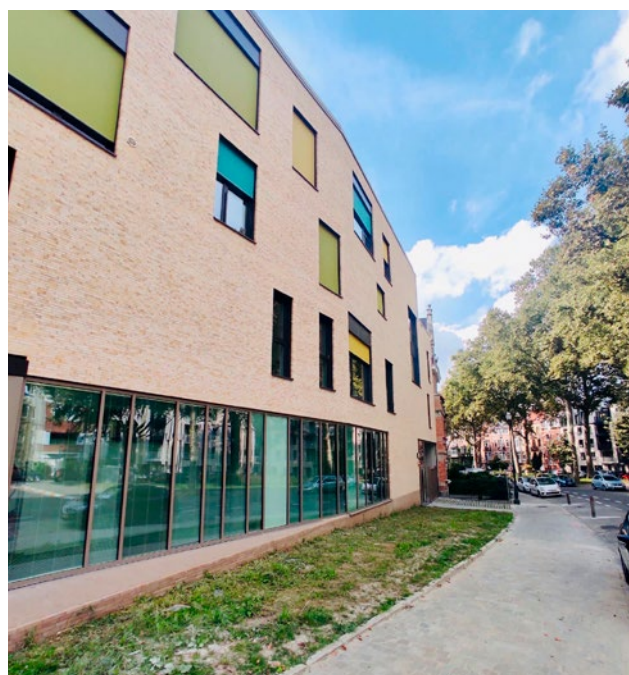
De nieuwe Altaïr-crèche in Schaarbeek
